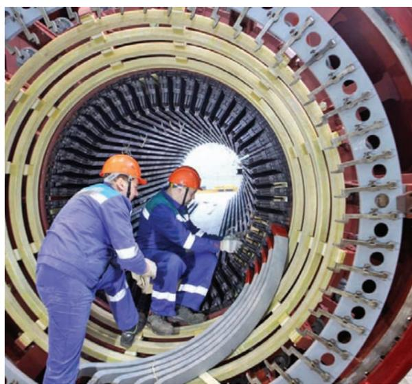
**В** рамках инвестиционной программы и ремонтной кампании на Костромской ГРЭС планируют модернизировать турбогенератор восьмого энергоблока. На станцию доставили ротор весом 55 тонн и возбудитель генератора. «Силовые машины» совместно со специалистами «КВАРЦ Групп» завершили сборку статора.
